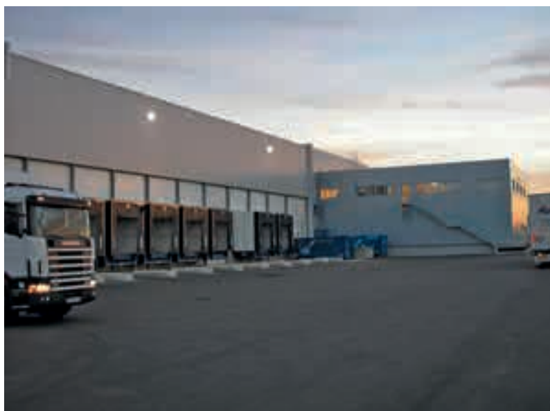
Pro à Pro distribution centre in Chaponnay (Lyon)
